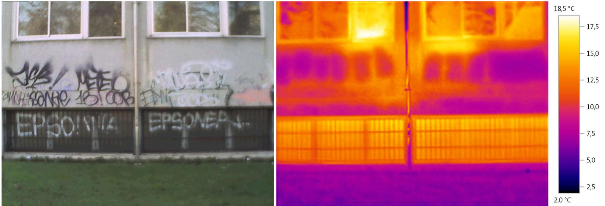
Si notano le perdite nei tamponamenti sottofinestra dove probabilmente ci sono i radiatori e lungo i telai delle finestre. Le finestre in basso, costituite da vetri singoli e telai in ferro, mostrano un riscaldamento di zone non utilizzate (seminterrati) ma riscaldate (!!)
