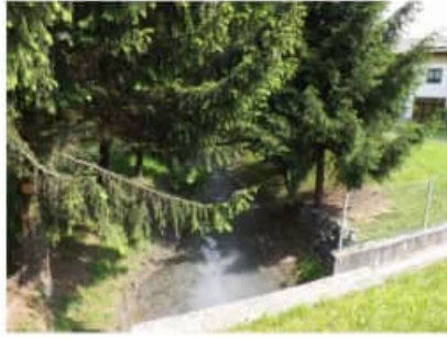
1: Ripristino della fascia perfluviale e della continuità morfologica dell'alveo
