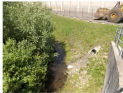
3: Ripristino della fascia perfluviale
