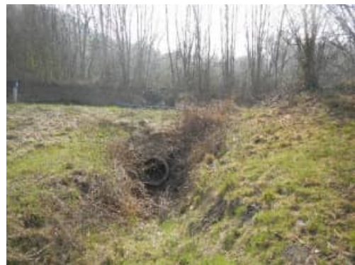
Manufatto per la raccolta e la distribuzione delle acque meteoriche da adeguare per la risalita degli anfibi (a sinistra) e imbocco di valle presente nell'ultimo tratto di intervento (a destra)
