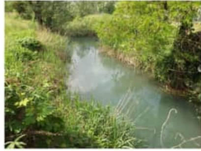
2: Ripristino della continuità morfologica dell'alveo
