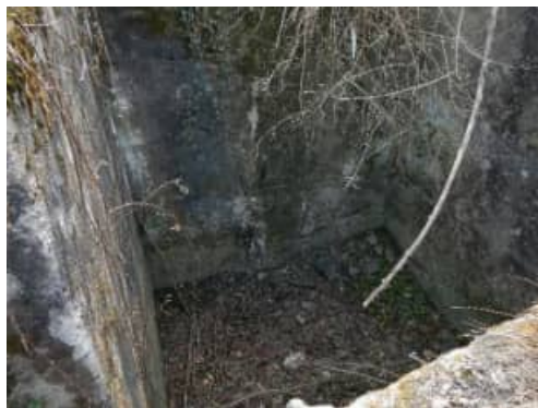
Manufatto per la raccolta e la distribuzione delle acque meteoriche da adeguare per la risalita degli anfibi (a sinistra) e imbocco di valle presente nell'ultimo tratto di intervento (a destra)
